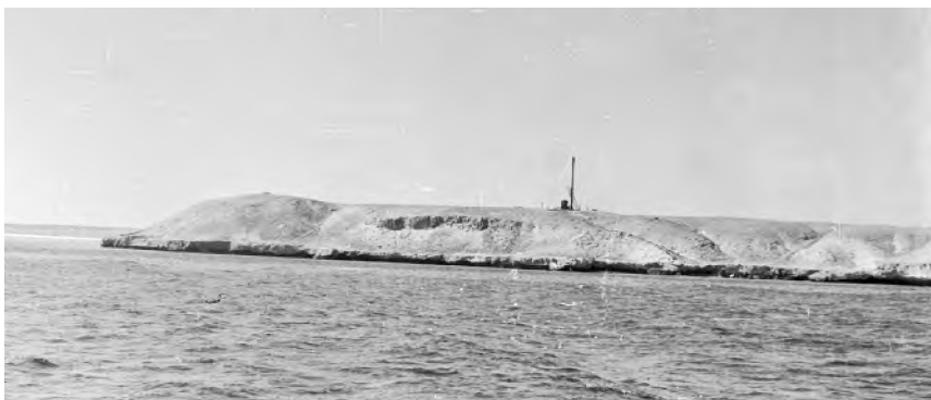
Восточный берег острова Губаль-Сагира. В районе маяка был расположен пост координирования «Губаль». 11 ноября 1974 г.
