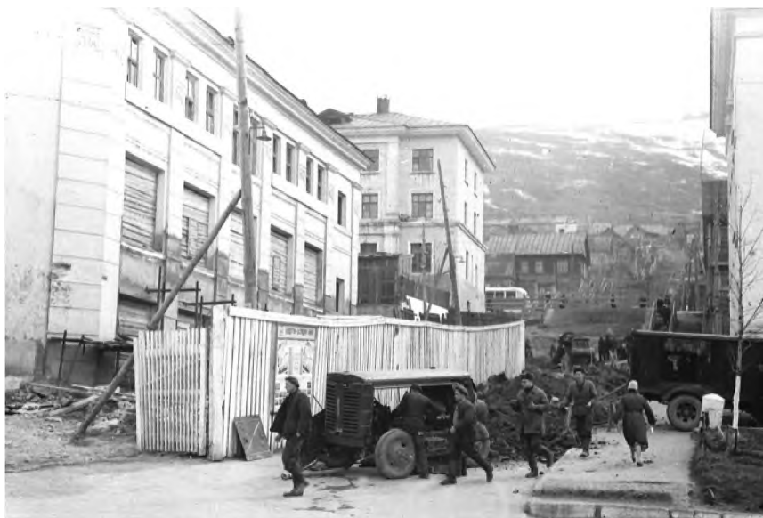
Строительство здания ГУМа на ул. Ленинской, 1960 г. (фото Г. З. Гайдукевича из фондов ККОМ)
