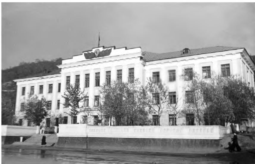
Здание Камчатского морского пароходства. Ранее здесь размещался Камчатский облисполком
