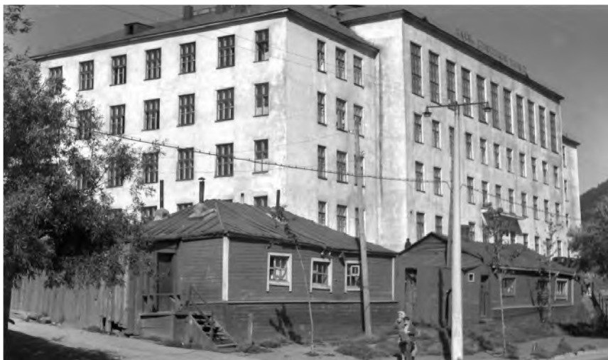
Главный корпус Петропавловск-Камчатского мореходного училища, 1967 г. На первом плане — бараки АКО постройки 1930-х гг. (фото Г. З. Гайдукевича из фондов ККОМ)
