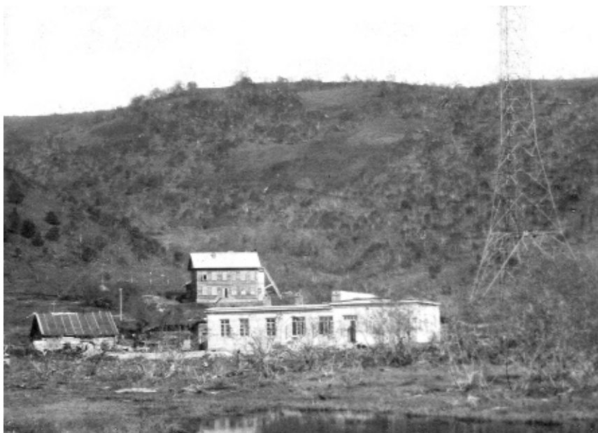
Одноэтажное железобетонное здание (второе) Петропавловской радиостанции и жилой дом служителей за ним (ККОМ, Ф 4251)
