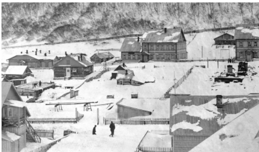
Городская панорама: на заднем плане — казначейские дома, справа — остатки сгоревшей почты (ККОМ, ГИ 29920/24)
