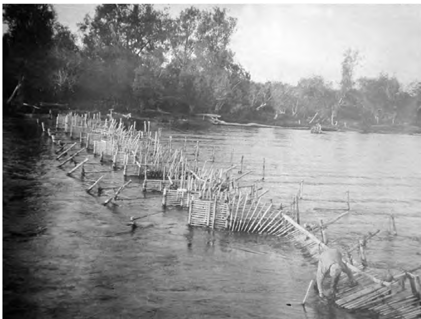
Запор на притоке реки Авачи
