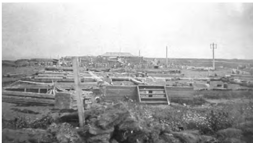
Разрушения завода Демби в Усть-Камчатске апрельским цунами 1923 г.
