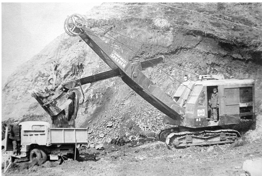
Строительство порта: погрузка скального грунта экскаватором «Спидер», 1944 г.
