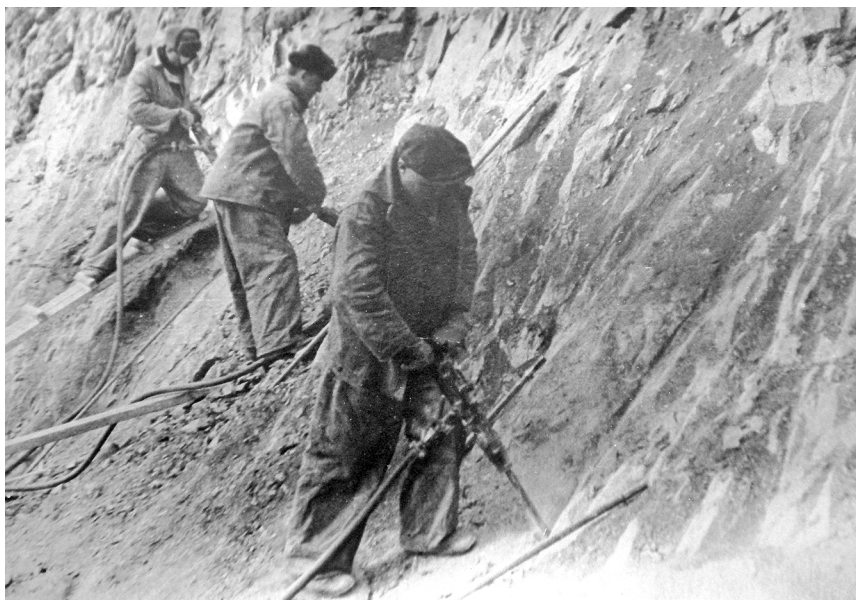
Строительство порта: разработка скалы при помощи отбойных молотков, 1944 г.
