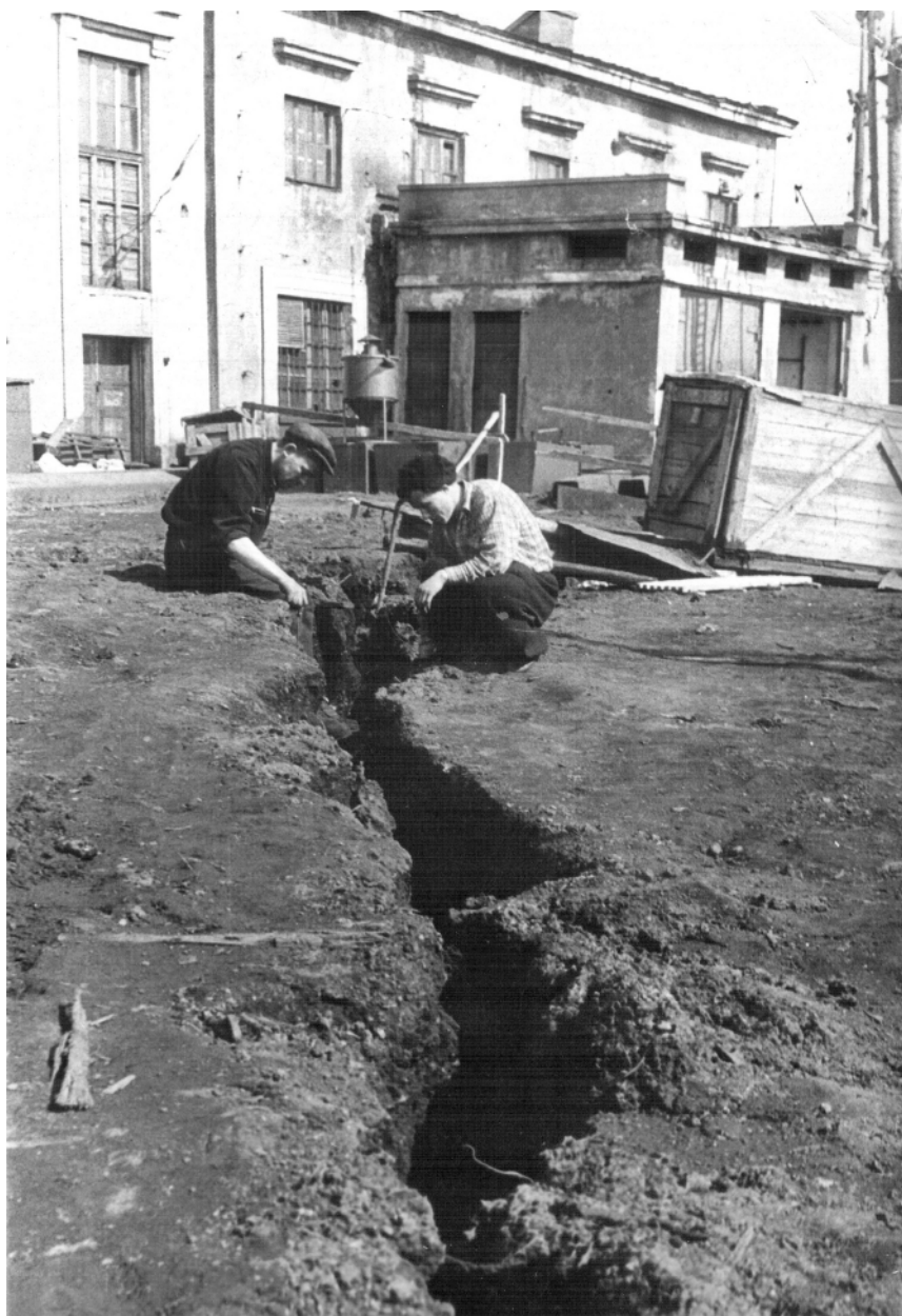
После землетрясения 4 мая 1959 г. Трещина в земле и повреждённый корпус цеха Петропавловской судовой верфи
