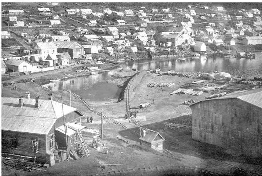
Строительство Петропавловского порта. Засыпка части акватории, 1932 г. (из фондов КГБУ ККОМ)
