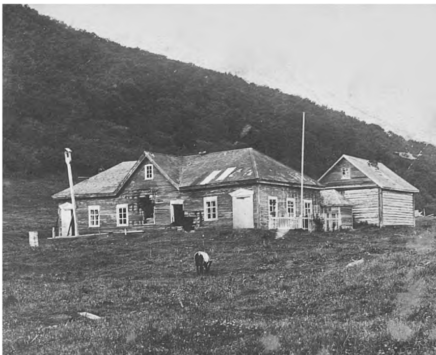
Здание Петропавловского окружного управления, повреждённое японской корабельной артиллерией в 1905 г.
