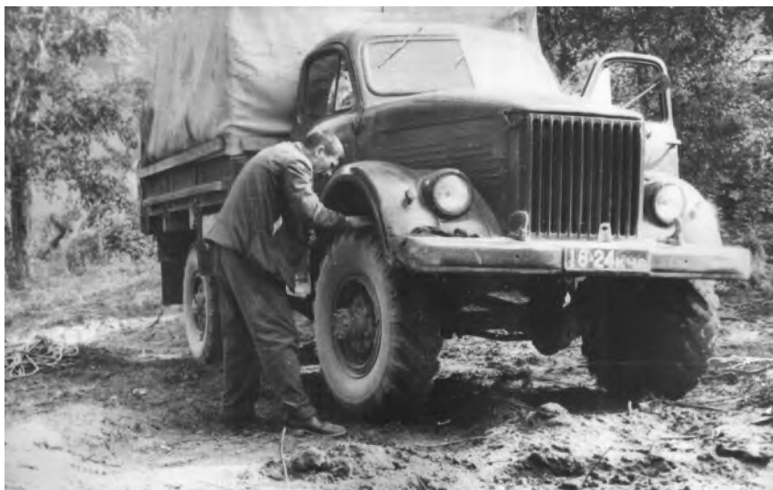
Водитель ГАЗ-63. Строительство ЛЭП в пос. Приморском, 1971 г. (из архива В. В. Брагина)
