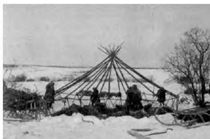
Установка остова юрты, 1920-е гг.
