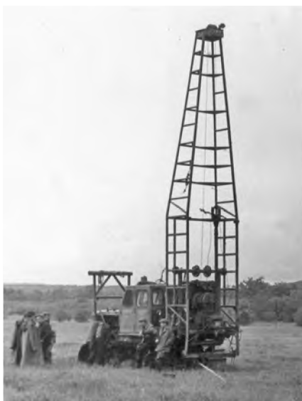
Бурение взрывных скважин, 1969 г. (из фондов ККОМ)
