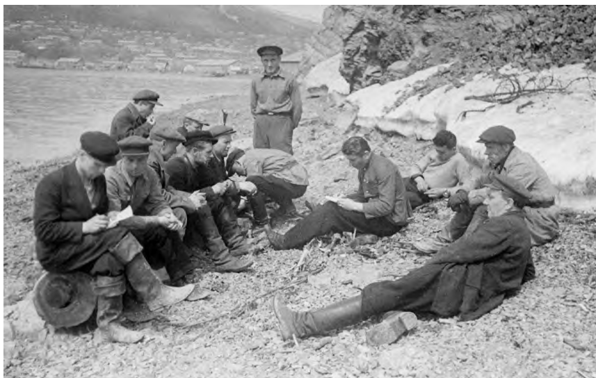
Курсанты всеобуча на строительстве дороги по ул. Набережной в Петропавловске, 1942 г. [ЖКМГИ 26547/221]
