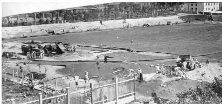
Строительство стадиона, 1959 г. [КОКМ НВФ 3149; 2644]
