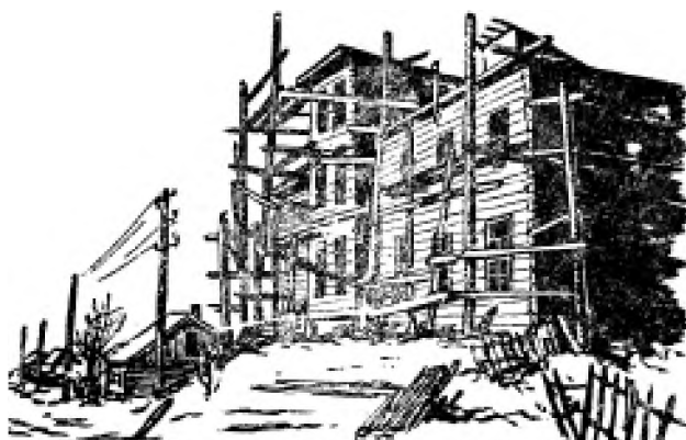
СТРОИТЕЛЬСТВО В ПЕТРОПАВЛОВСКЕ. Постройка нового дома на Партизанской улице.
