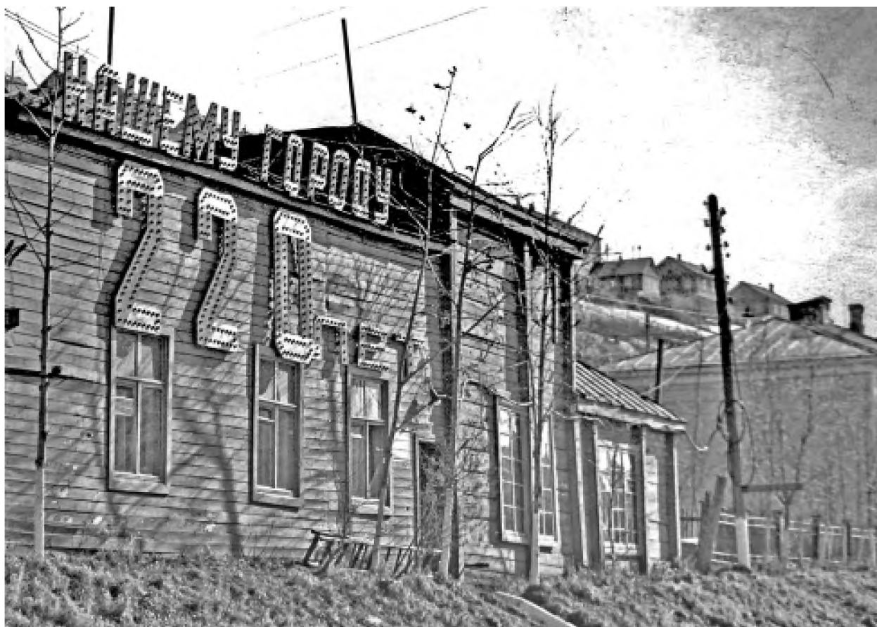
Здание городской электростанции, построенное в 1927—1928 гг. Улица Советская, 20. Фотография 1960 г. ККМГИ 27595/228
