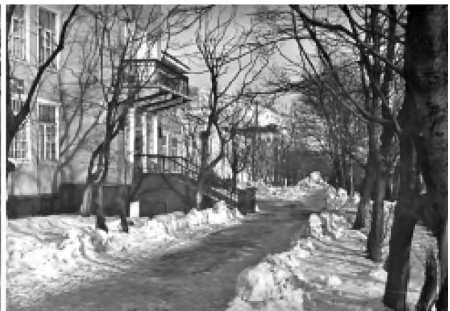
Вход в здание Камчатрыбпрома, 1960-е гг. НВФ 2650
