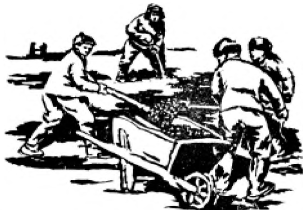
Подготовка к постройке жилых домов в Агломерации. Рис. худ. А. Пестелов.
